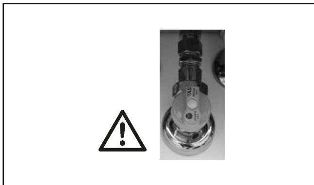
Рисунок: Подвод газа: Опасность отравления и взрыва из-за утечки газа
