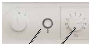
Кнопка деблокирования Регулятор температуры ГВС
