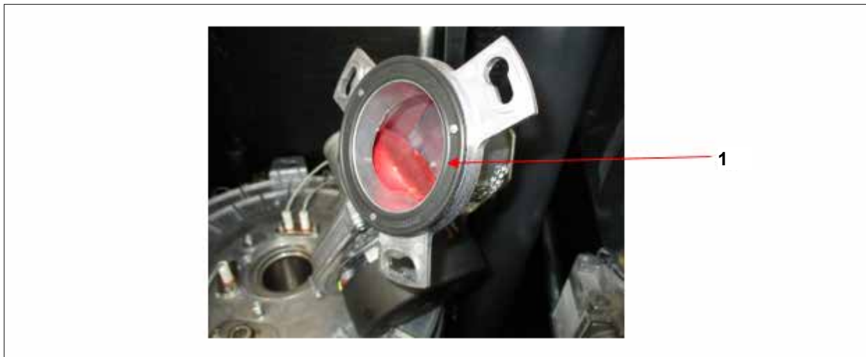
Рис. 5.9 Замена уплотнения горелки
