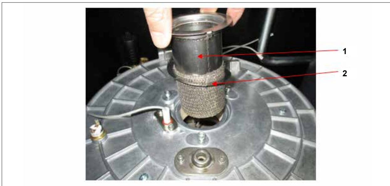
Рис. 5.10 Демонтаж горелки
