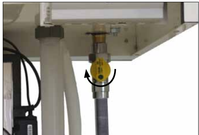
Illustration : Raccord de gaz Danger d'intoxication et d'explosion dû aux émanations de gaz
