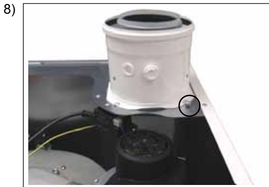
8) Nach Abnahme des oberen Verkleidungsdeckels Blechschraube Arretierung Luft- / Abgasrohr lösen.
