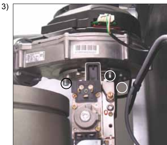
Отсоединить смесительную камеру от вентилятора (отвинтив 3 винта с внутренним шестигранником 5 мм), в случае необходимости отсоединить воздухозаборный патрубок
