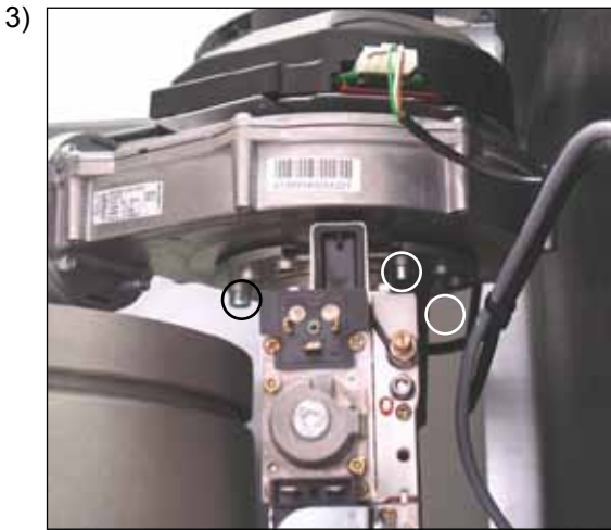
Karışım odasını vantilatörden (3 adet Allen cıvata 5mm) çözün ve gerekirse hava emiş borusunu çekin
