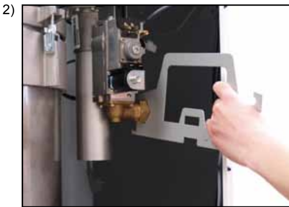
Отсоединить подключение газа к комбинированному газовому клапану
