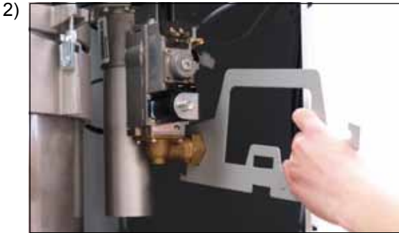
Løsn gastilslutning ved gasarmaturet
