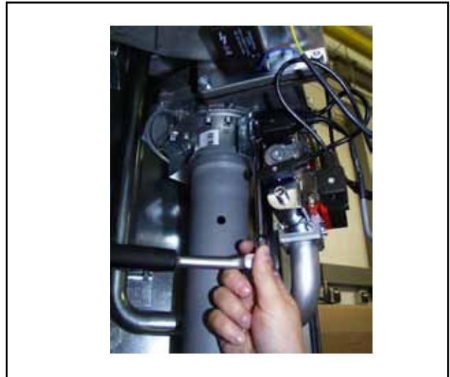
Рис.: Открутить винты между вентилятором и смесительной камерой
