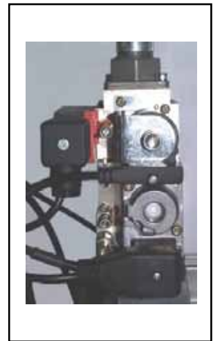
Рис.: Газовый комбинированный клапан Опасность поражения электрическим током Опасность отравления и взрыва в случае утечки газа
