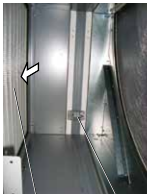
Соединительный элемент Демонтировать фильтр
