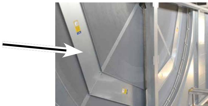
Материал, необходимый для монтажа роторного теплообменника, находится внутри нижней части корпуса (у двигателя) со стороны обслуживания. Соединительный материал (винты, гайки) для подсоединения к установке кондиционирования входит в комплект поставки этой установки (а не в комплект роторного теплообменника).
