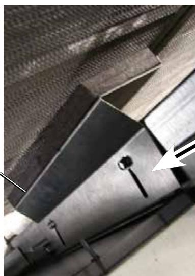
Если на роторном теплообменнике транспортировочные крепления использованы для сегментов ротора, то эти крепления также требуется убрать.
