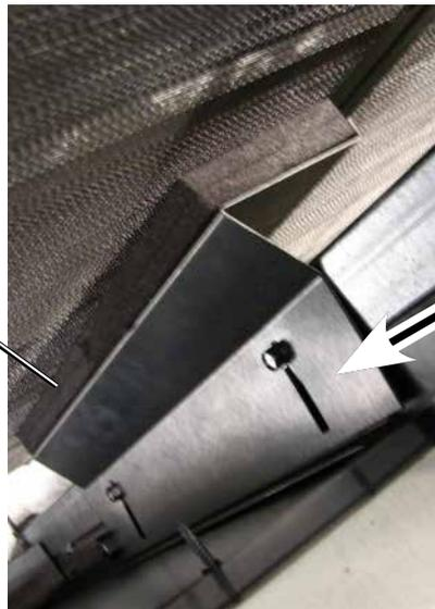
Si en el recuperador de calor rotativo se han utilizado fijaciones de transporte para los segmentos del rotor, estas deben retirarse también.
