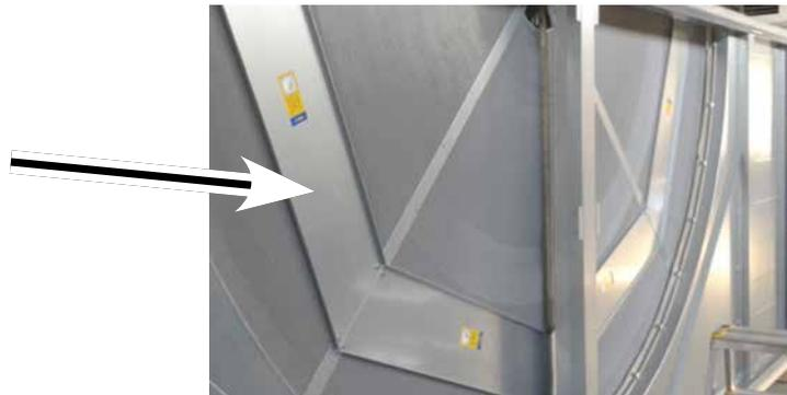
Das Material für die RWT-Montage ist innerhalb des Gehäuseunterteils (beim Motor) auf der Bedienseite gelagert. Das Verbindungsmaterial (Schrauben, Muttern) für die Verbindung zum Klimagerät ist im Lieferumfang des Klimagerätes (nicht im Lieferumfang des RWT's)
