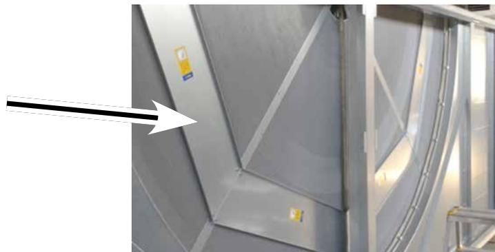
El material para el montaje del recuperador de calor rotativo se almacena dentro de la parte inferior de la carcasa (junto al motor), en el lado de manejo. El material para la unión (tornillos, tuercas) con el climatizador se incluye en el volumen de suministro de este (no en el del recuperador de calor rotativo).
