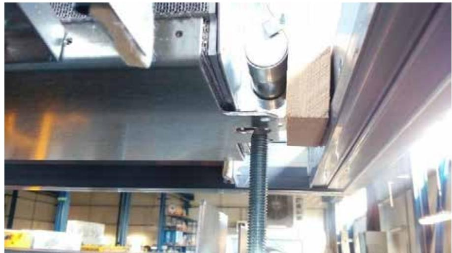
Лист кожуха нижней половины ротора должен войти между тепловым аккумулятором и кожухом верхней половины ротора.
