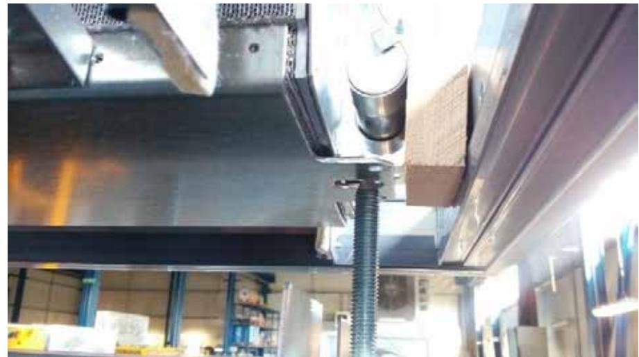
Das Blech aus der Ummantelung der unteren Rotorhälfte muss zwischen die Speichermasse und der Ummantelung der oberen Rotorhälfte eingeschoben werden.
