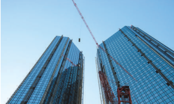
Подъем строительным краном
