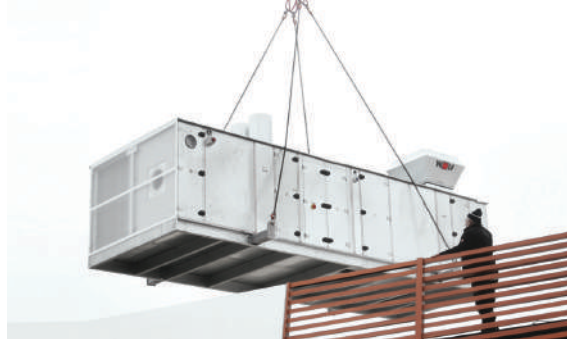
Установка с помощью крана на крыше объекта общественного питания
