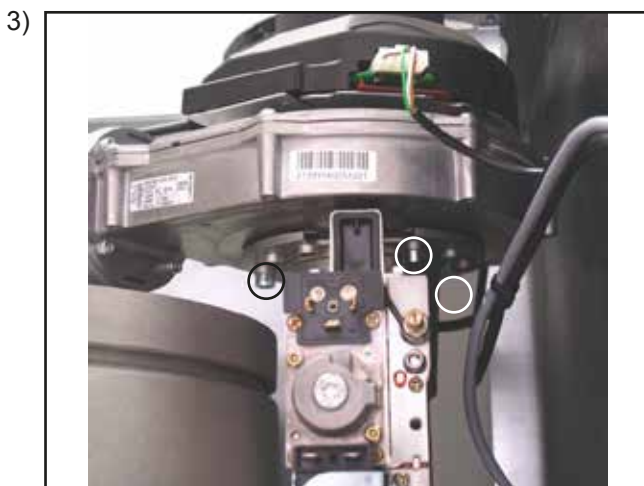
Отсоединить смесительную камеру от вентилятора (отвинтив 3 винта с внутренним шестигранником 5 мм), в случае необходимости отсоединить воздухозаборный патрубок.
