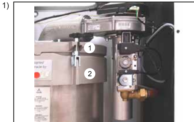
Отсоединить штекеры ①② (предварительно ослабить винты с крестовым шлицем)
