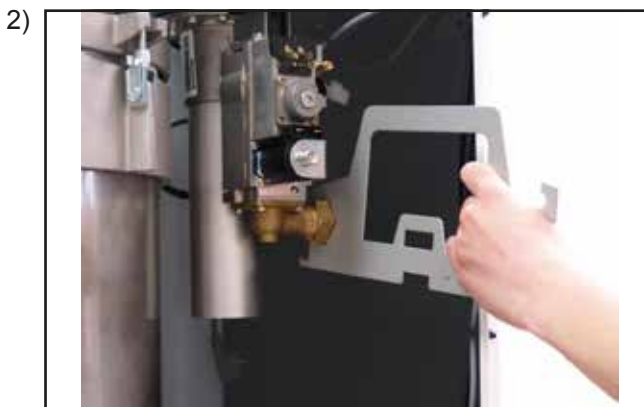
Открутить резьбовое соединение подвода газа на комбинированном газовом клапане.
