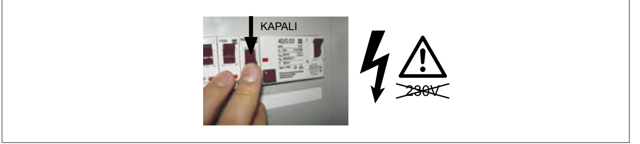
Şek. 3.1 Sistem voltajının kesilmesi
