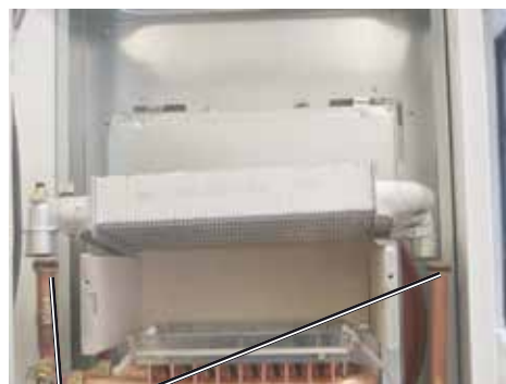
Рис: Демонтаж теплообменника сетевой воды
