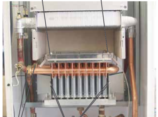
Крепежные болты Компоненты горелки [2]
