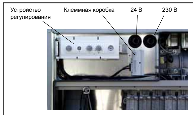
Рис.: Устройство регулирования MGK-170/210/250/300
